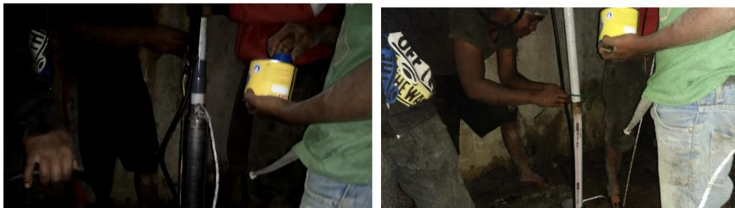
Gambar 6. Instalasi pipa dan pompa
