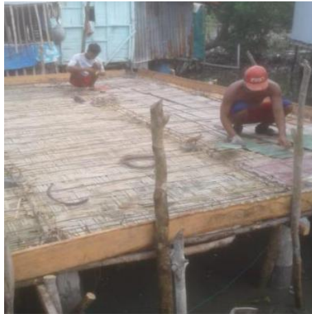
Gambar 4. Pekerjaan pondasi Taman Bermain Kampung Nelayan Seberang.
