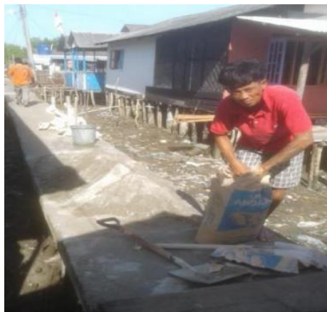
Gambar 3. Proses Pembuatan Taman Bermain Kampung Nelayan Seberang
