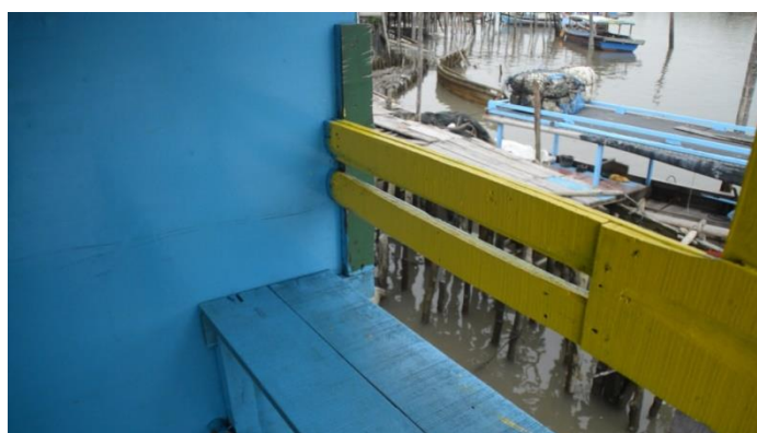
Gambar 3. Hasil Renovasi Interior Pondok Baca Anak Kampung Nelayan Seberang
