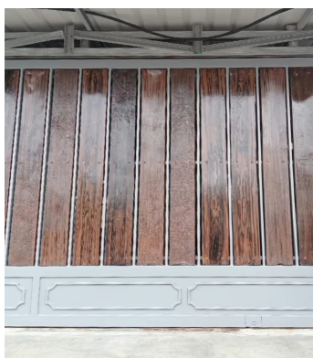
Gambar 4. Prototipe papan HDPE pada instalasi aktual
