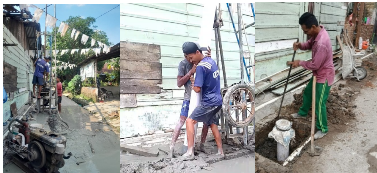
Gambar 6. Dokumentasi proses pelaksanaan pembangunan Groundwater Recharge
