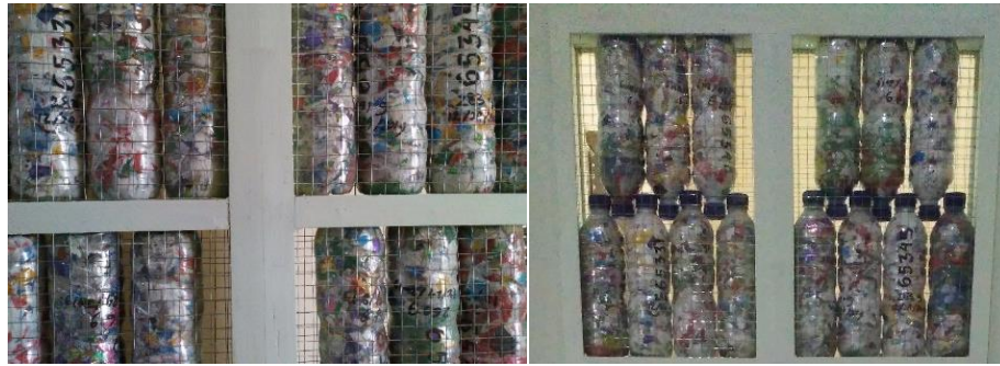
Gambar. 4. Ecobrick pada pintu
