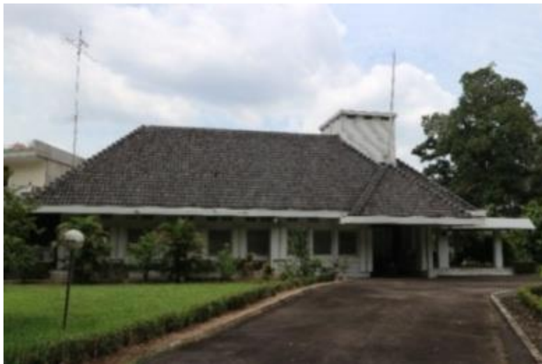
Gambar 2. Rumah Tinggal Sudut Jl. Slamet Riadi & Jl. Jend. Sudirman Sumber: Dokumentasi Survey
