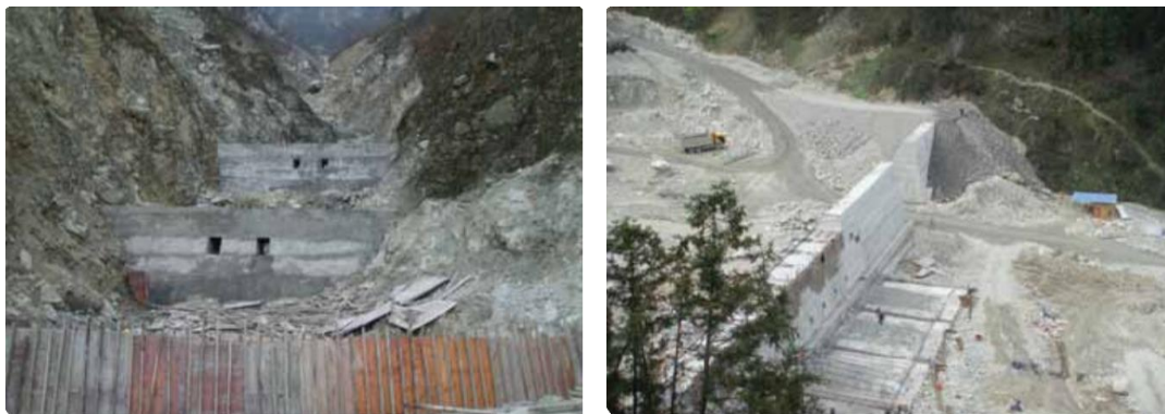
Gambar 2. Upaya Pengendalian Banjir Bandang Dengan Rekayasa Struktural
