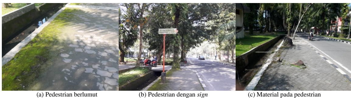
Gambar 15. Pedestrian eksisting (sumber: Dokumentasi Pribadi, 2018)
