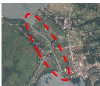
Gambar 5. Kondisi Eksisting KanalTano Ponggol Sumber: analisa pribadi, 2018
