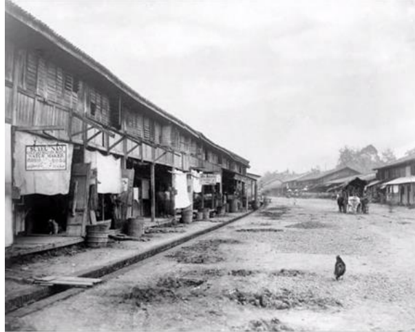
Gambar 4. Deretan Ruko bermaterial kayu di Kesawan (Sumber: Tropenmuseum Royal Tropical Institute)
