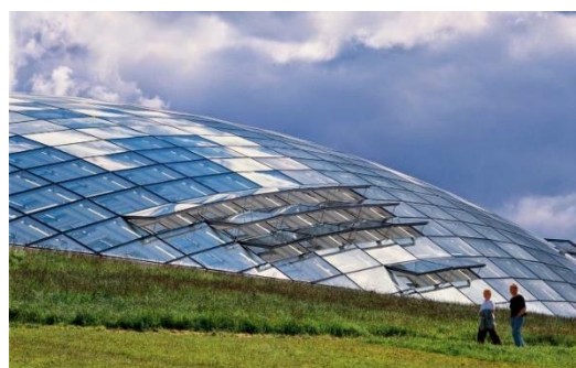
Gambar 3. Penggunaan dome rangka baja pada The Great Glasshouse Sumber: walesonline.co.uk
