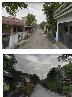
(c) Koridor Jalan Tipe-B
