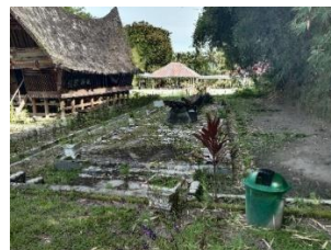
Gambar 11. Solu Bolon Yang Sudah Rusak Dan Tidak Terawat
