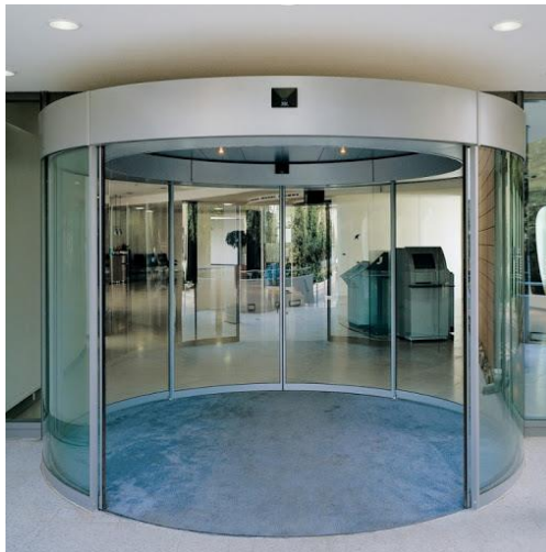
Gambar 7. Pintu dengan sensor untuk terbuka [12]
