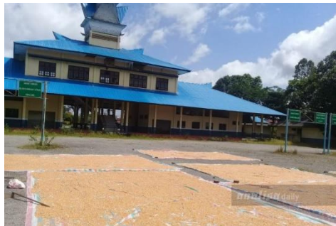
Gambar 1. Tampak depan Terminal Sitinjo (4)
