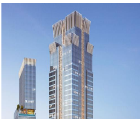
Gambar 8. Bentuk Atap dari Sopo Del Office
