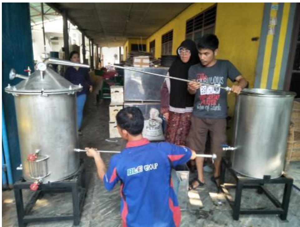
Gambar 3. Pemasangan Alat Suling
