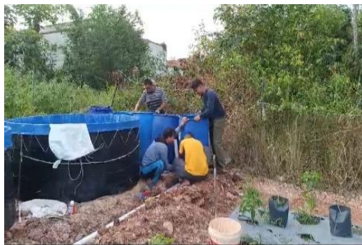
(c) Pemasangan Rangka Kolam Bundar
