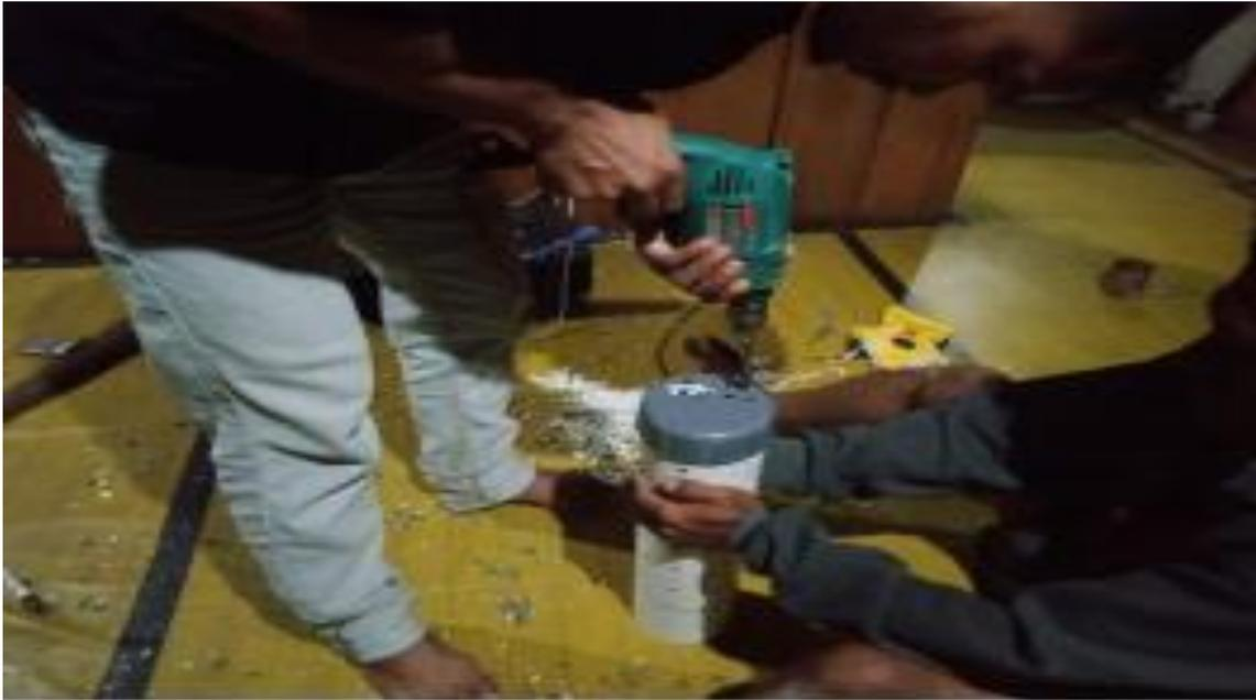
Gambar 2. Pembuatan LRB menggunakan pipa paralon
