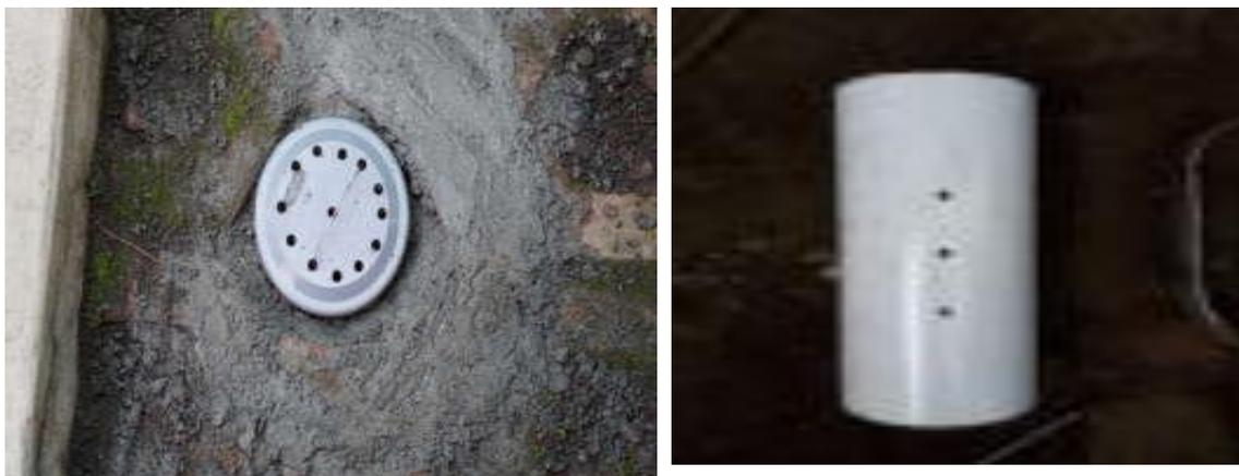
Gambar 5. Sketsa pemasangan pipa lubang resapan biopori
