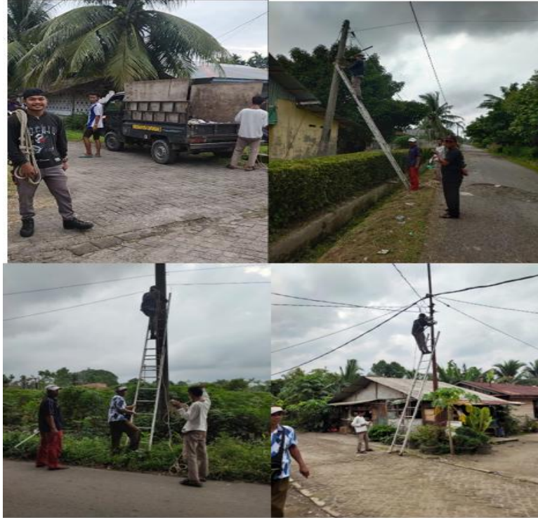
Gambar 6. Proses instalasi lampu penerangan jalan umum mode otomatis di Desa Tuntungan II
